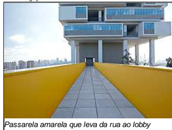
Passarela amarela que leva da rua ao lobby
